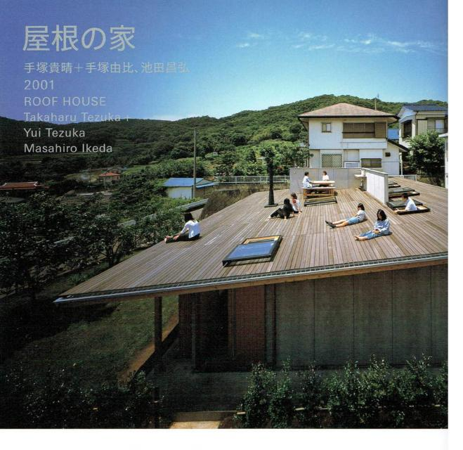
「屋根の上でご飯を食べたい」というクライ アントの何気ない言葉を、ヴィスタに向かっ て開口を大きくとるのではなく、緩やかな大 屋根の面を向ける鮮やかなアイディアで切り 返した。約100mの平面形に約140mの屋根が 地面の勾配に合わせて架けられ、テーブルや キッチンが備え付けられている。それぞれの 機能(アクティビティ)に天窓が用意され、 合計で屋根には8つの開閉可能な天窓が設け られた。総厚わずか150mmの極薄の屋根は、 910mm×910mmグリッドの木造格子梁で、 12mm厚の構造用合板がその両面に張られて 剛性が保たれている。低く抑えられた軒から
