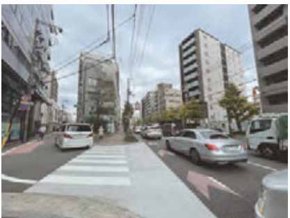
軸ズレにより無秩序に建つビル
