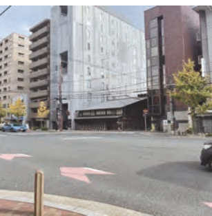
軸ズレにより無秩序に建つビル
