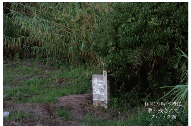
敷地の裏にあった住宅は台風の被害を受け解体された。 敷地南側の崖に対面するように配され、置き去りにされたブロック塀
