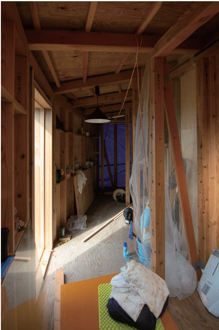
施工途中 北側を見る
